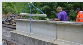
3. Montera tätlist och lyft blocket på plats
