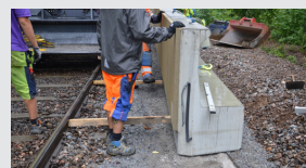
4. Kontrollera distans från spår på plats
