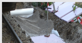
1. Gräv bort 20cm ur banvallen. Placera ut fiberduk och fyll på med kross.
